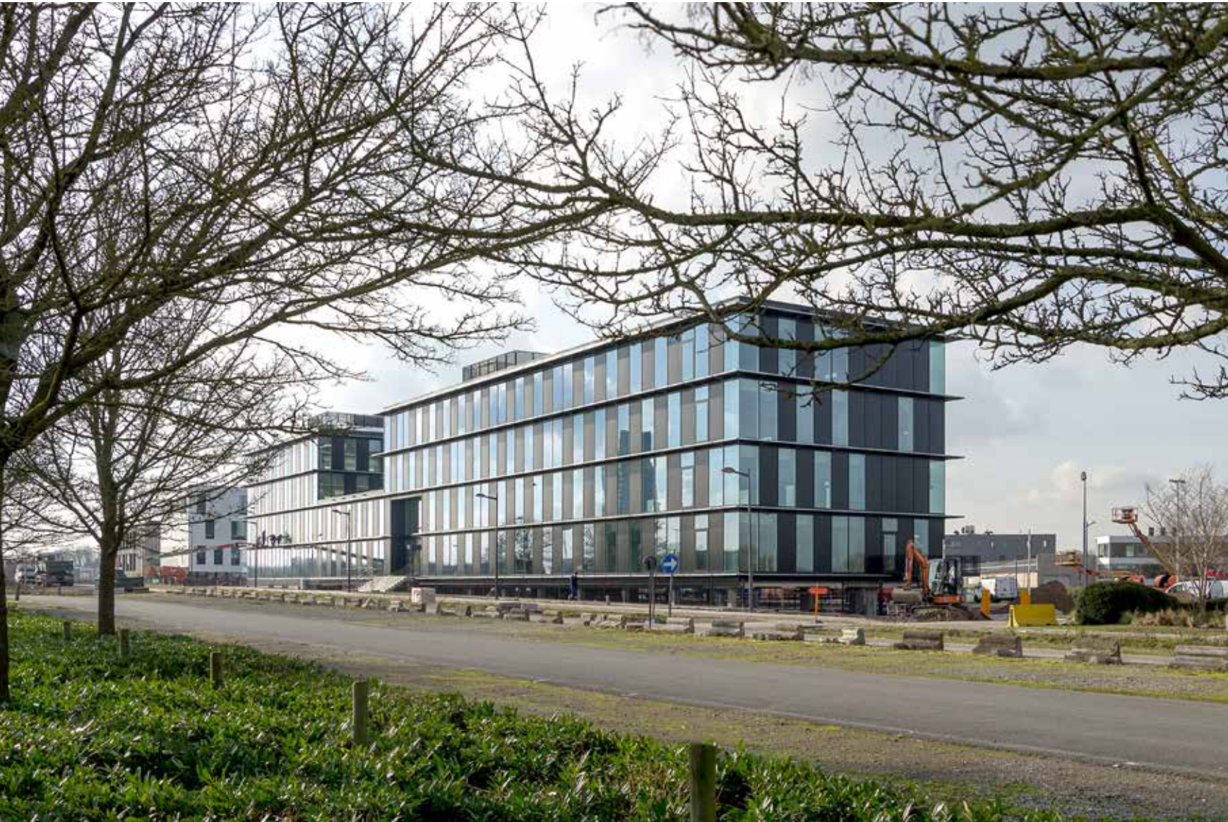
Het gebouw bestaat uit twee volumes, die met elkaar zijn verbonden via een tussenvolume van twee bouwlagen.
