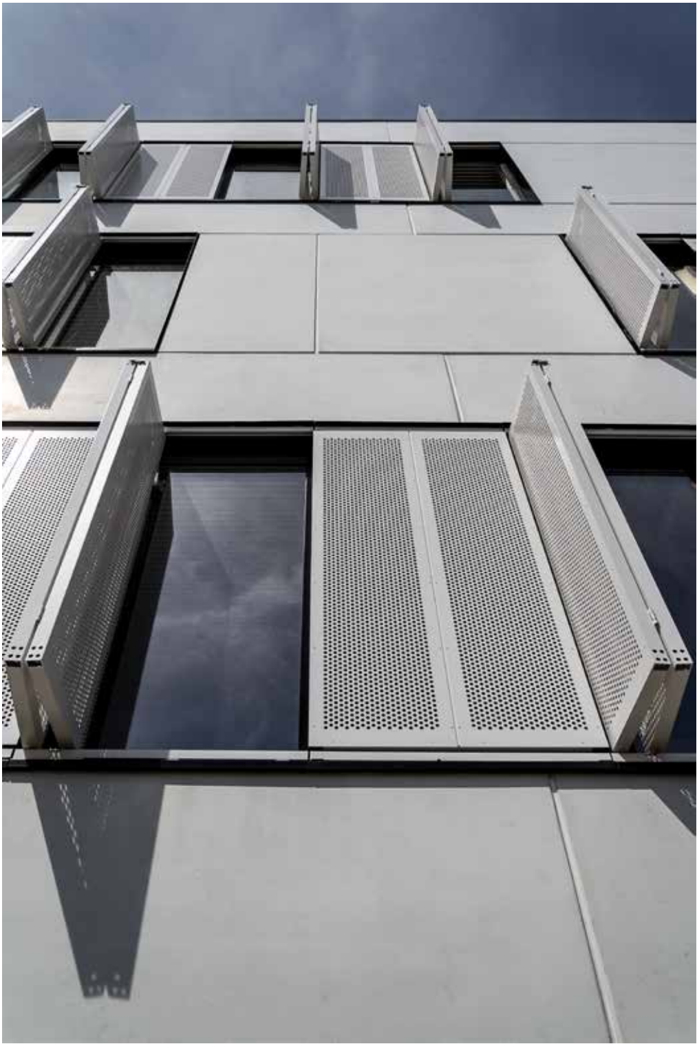
Aan de zuidoost- en zuidwestgevel zijn de ramen uitgerust met witte gemotoriseerde, metalen vouwpanelen met een specifieke perforatie.
